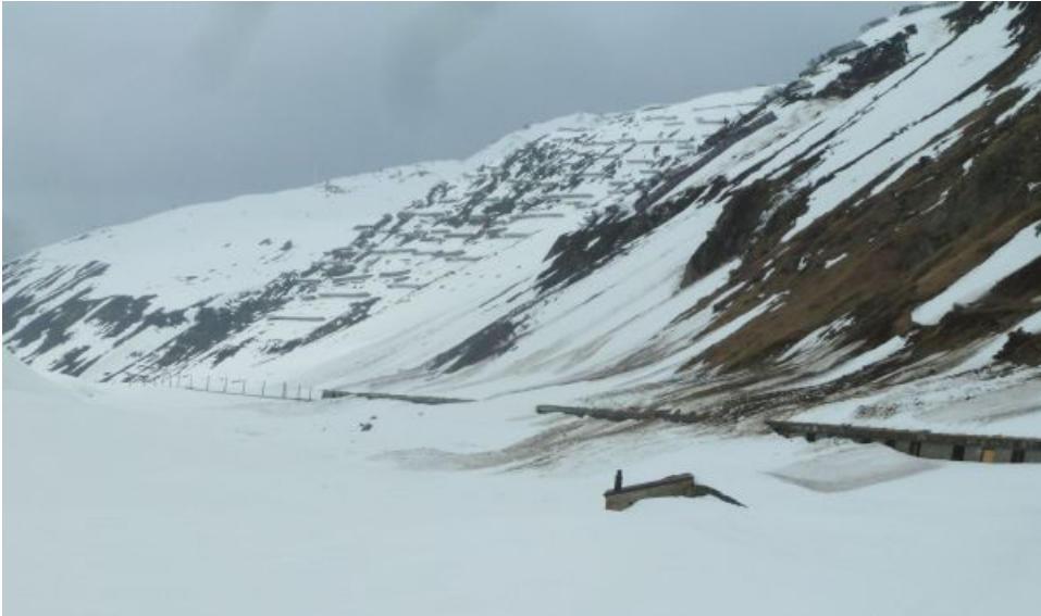
Zahlreiche Lawinerverbauungen dienen am Oberalppass (2044 m, Tujetsch/Andermatt, GR/UR) der Sicherung von Strasse und Bahntrasse. Im Vordergrund wurde eine Nassschneelawine über die Lawinengalerie abgeleitet. Im Hintergrund sind diverse Anrissverbauungen in einem steilen Südhang zu erkennen (Foto: N. Levy-Schmid, 04.04.2016).
