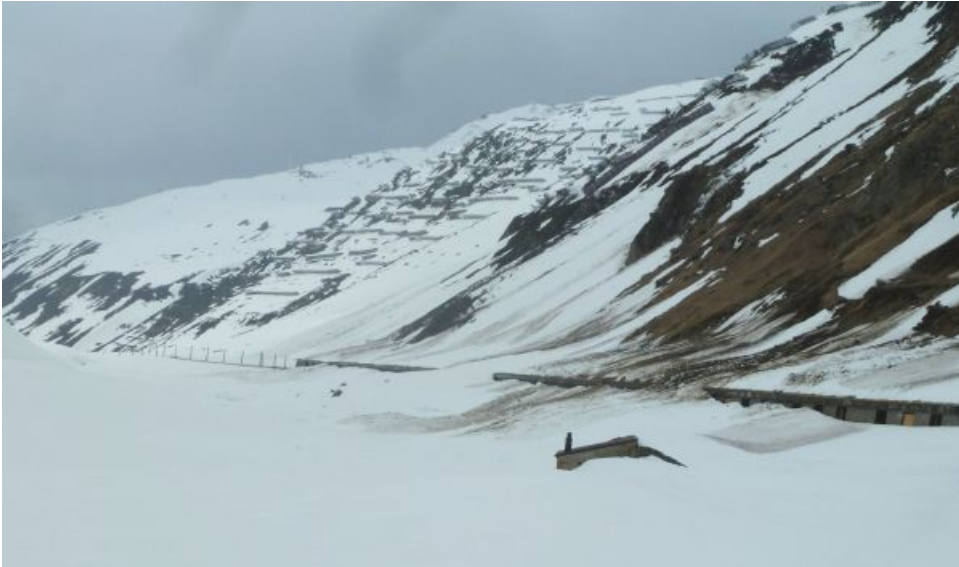
Zahlreiche Lawinerverbauungen dienen am Oberalppass (2044 m, Tujetsch/Andermatt, GR/UR) der Sicherung von Strasse und Bahntrasse. Im Vordergrund wurde eine Nassschneelawine über die Lawinengalerie abgeleitet. Im Hintergrund sind diverse Anrissverbauungen in einem steilen Südhang zu erkennen (Foto: N. Levy-Schmid, 04.04.2016).
