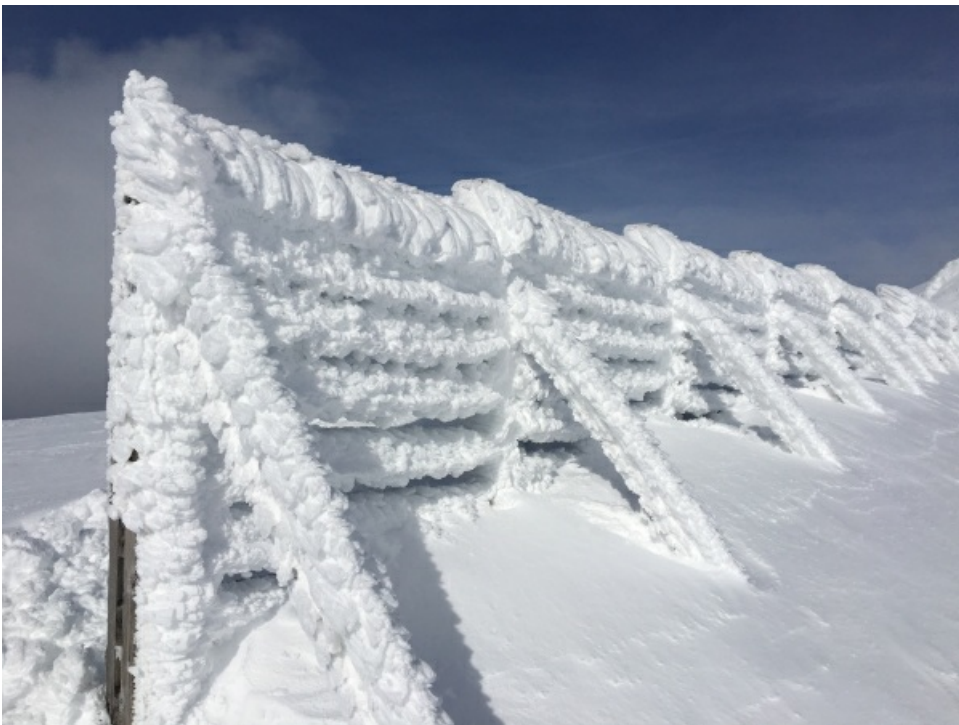
Le givre opaque se forme en direction du vent, typiquement sur des clôtures, des pylones ou des rochers. Ces constructions servent à empêcher aux grandes quantités de neige soufflée de s'accumuler dans les pentes en contrebas (Col de Balme, 2204 m, Trient, VS) (Photo: J.-L. Lugon, 26.02.2016).
