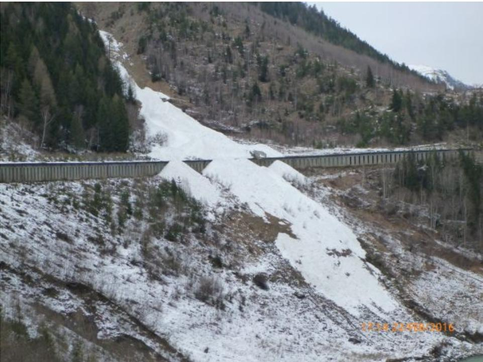
*Eine Lawingalerie ist eine permanente bauliche Schutzmassnahme. Im Bild ein gutes Exempel für deren Wirksamkeit auf der Unterengadiner Hauptstrasse (Foto: P. Caviezel, 21.02.2016).*
