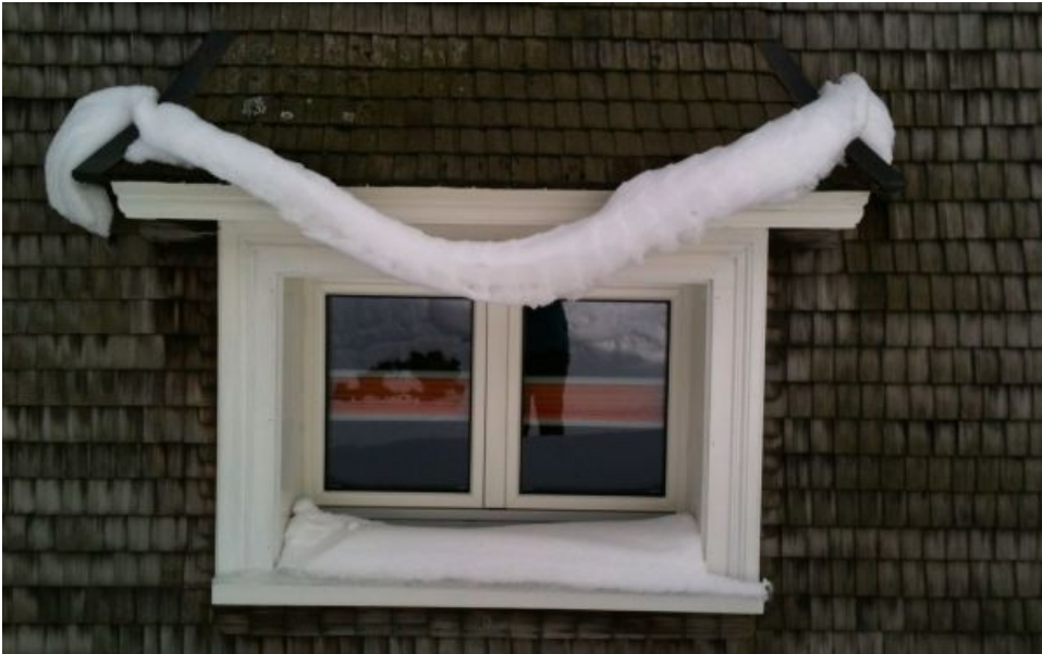
Durch die geringe Eigenlast kommt es bei warmen Temperaturen oft zu einer viskosen Verformung des Schnees, wobei die Kohäsion zwischen den einzelnen Schneekristallen dafür sorgt, dass sich das Band der Schwerkraft widersetzt (Foto: P. Diener, 22.01.2016)
