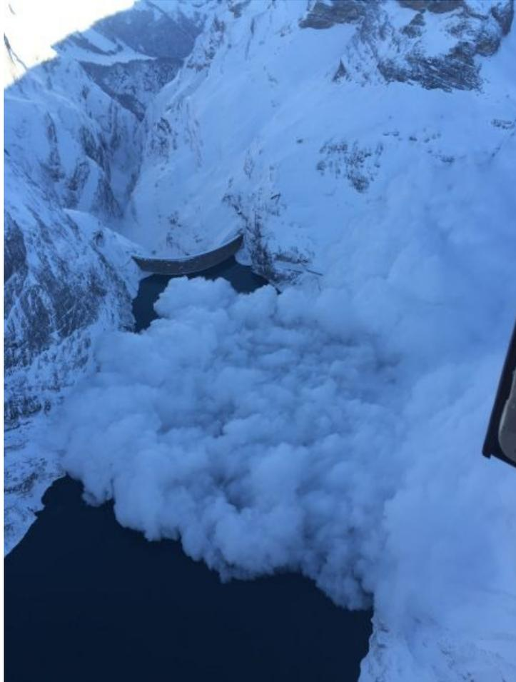
*Photo 1: Avalanche déclenchée au moyen d'explosifs sur une pente très raide exposée à l'ouest afin de sécuriser le chantier de Linth-Limmeren (Linth, GL). La rupture s'est propagée sur plus de 200 m de largeur dans les couches profondes de neige ancienne. Pour donner un ordre de grandeur: le niveau de l'eau est situé 40 m en dessous du sommet du mur (photo: R. Stüssi, 18.01.2016).*
