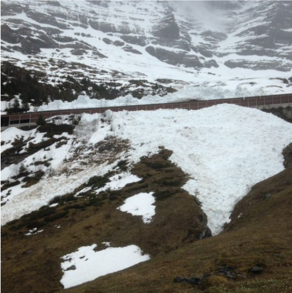
Gut gibt es Lawinengalerien. Abgang einer Lawine aus der Eigernordwand über die Chrutmatten-Galerie der Jungfraubahn am 03.05. (Foto: W. Von Gunten, 03.05.2015).
