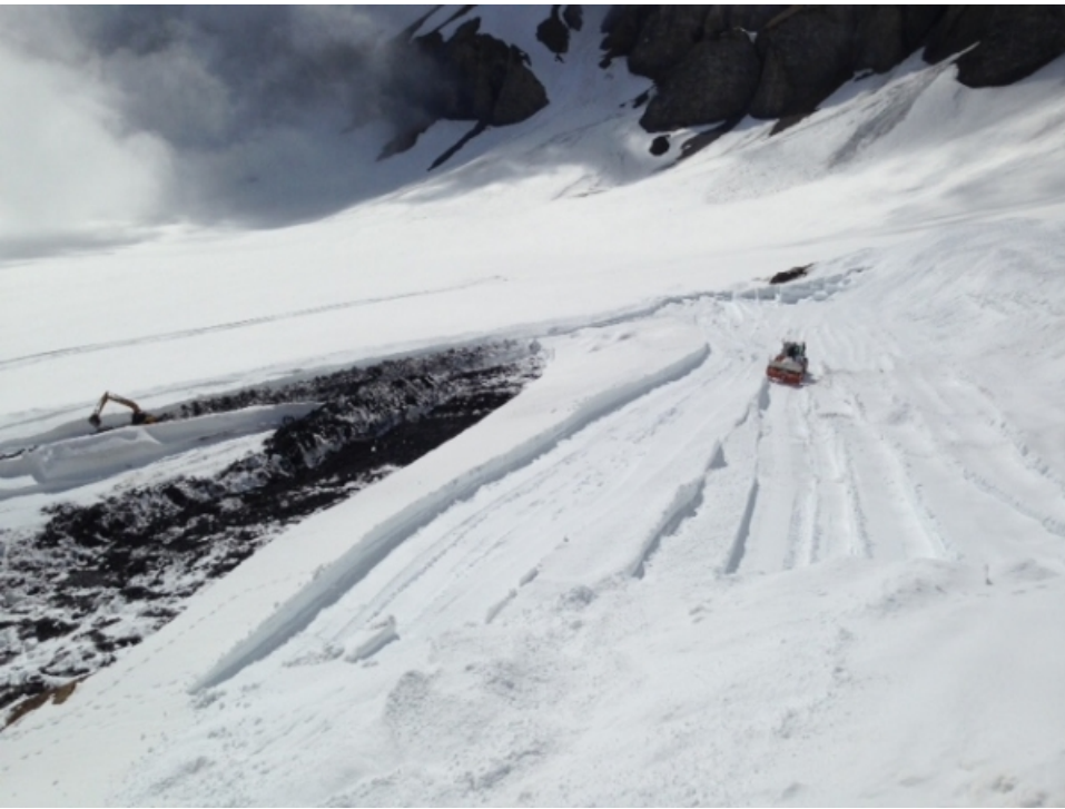
Schneeräumarbeiten auf der Baustelle am Damm des Lac du Vieux Emosson auf rund 2200 m (Foto: J.L. Lugon, 28.04.2015).
