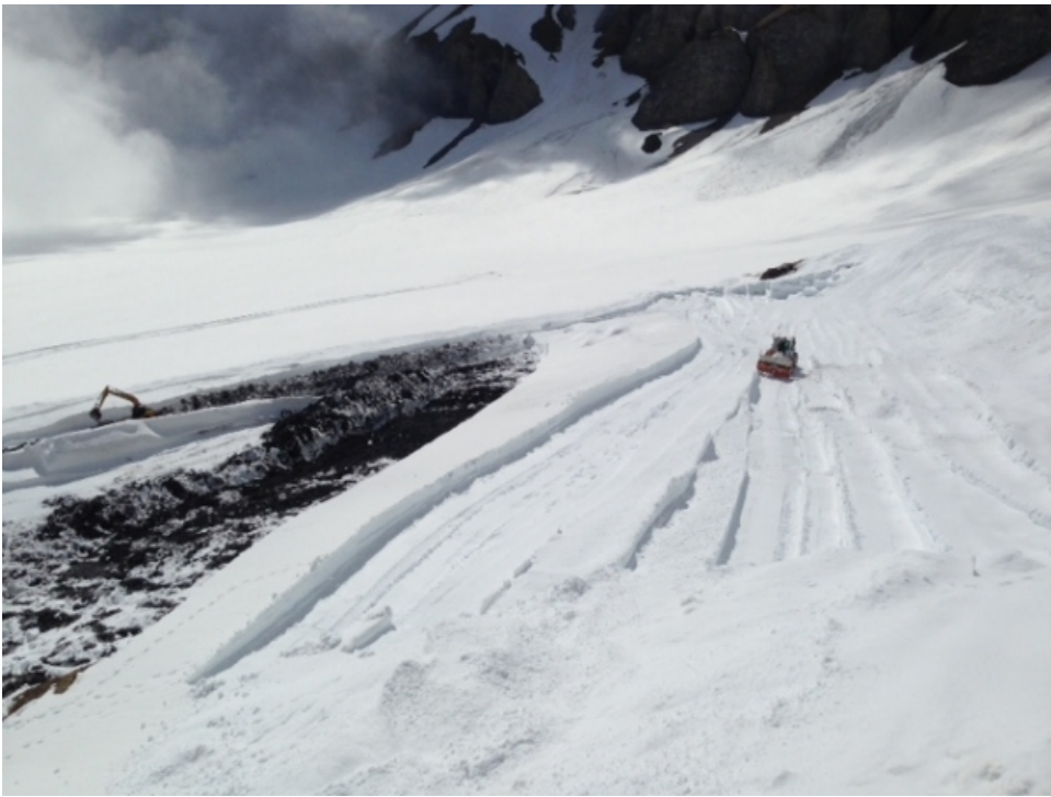
Schneeräumarbeiten auf der Baustelle am Damm des Lac du Vieux Emosson auf rund 2200 m (Foto: J.L. Lugon, 28.04.2015).
