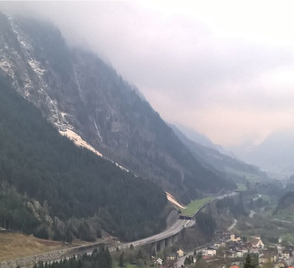
Alle Jahre wieder: die Wierplangglai zwischen Wassen und Gurtellen, UR. Das Anrissgebiet ist westlich exponiert auf rund 2000 m, der Auslauf auf der Galerie der Gotthardautobahn auf 750 m. Die Kantonsstrasse wurde nicht verschüttet (Foto: S. Baumann, 18.04.2015).
