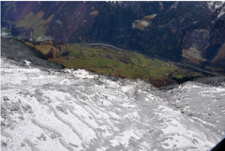
Die Lawinverbauungen im Kanton Uri sind noch wenig gefüllt. Blick ins Urner Reusstal (Foto: SLF/S. Margreth, 17.12.2014).
