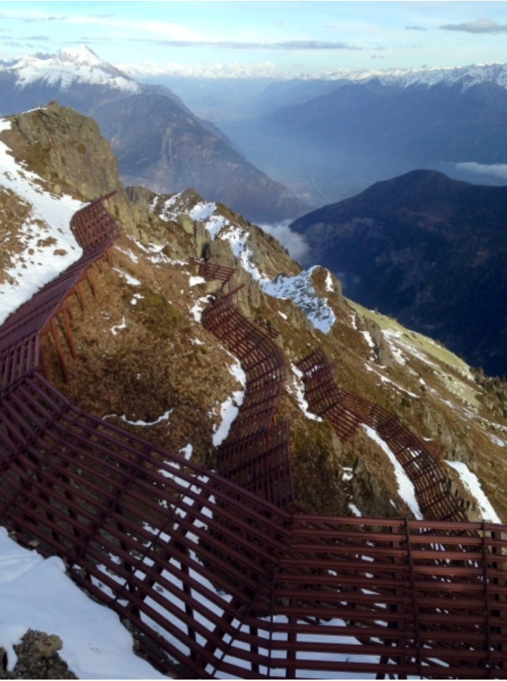
Les paravalanche (de 6 m) sont pas saturés de neige, La Barne au-dessus de Finhaut, VS (photo: J.L. Ligon, 25.11.2014).
