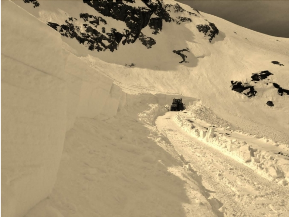
Déneigement au collecteur ouest de la décharge de Nant de Drance sur le chantier d'Emosson (Salvan, VS). Sur cette pente nord à 2010 m d'altitude la couche de sable est encore bien visible (photo: J.-L. Lugon, 02.04.2014).
