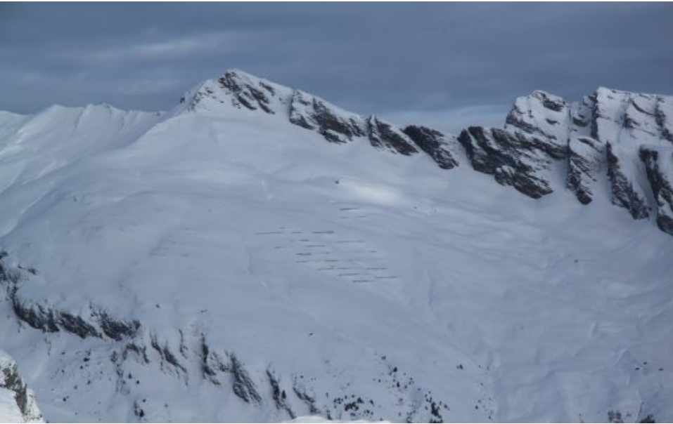
Die Lawinverbauungen auf der Schollenalp am Schollenhorn (2732 m) (Rheinwald, GR) sind schon recht voll (Foto: SLF/L. Dürr, 14.02.14).
