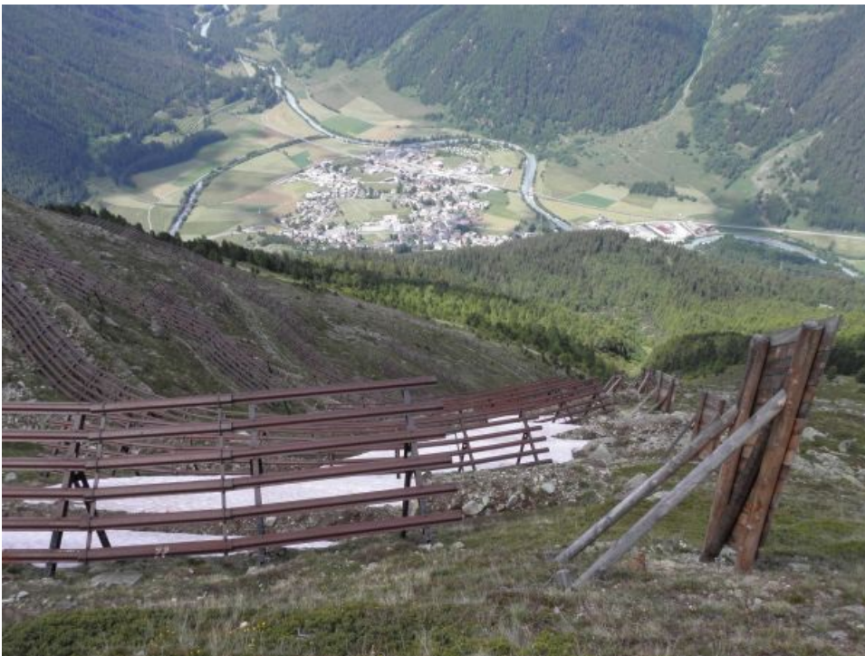
Lawinverbauungen am Munt Baselgia (2682 m) oberhalb von Zernez (Engadin, GR). Die Kolktafeln rechts im Bild auf dem Geländerücken verhindern dort die Wächtenbildung und die Bildung homogener Triebsschneeschichten. Der Triebsschnee wird in den Stützverbauungen abgelagert. So wird ein Anreissen von Lawinen seitlich der Stützverbauungen verhindert. Die Stützverbauungen verhindern das Anbrechen von Lawinen und schützen so den darunterliegenden Wald und die Ortschaft Zernez (Foto: SLF / Th. Stucki, 05.07.2013).
