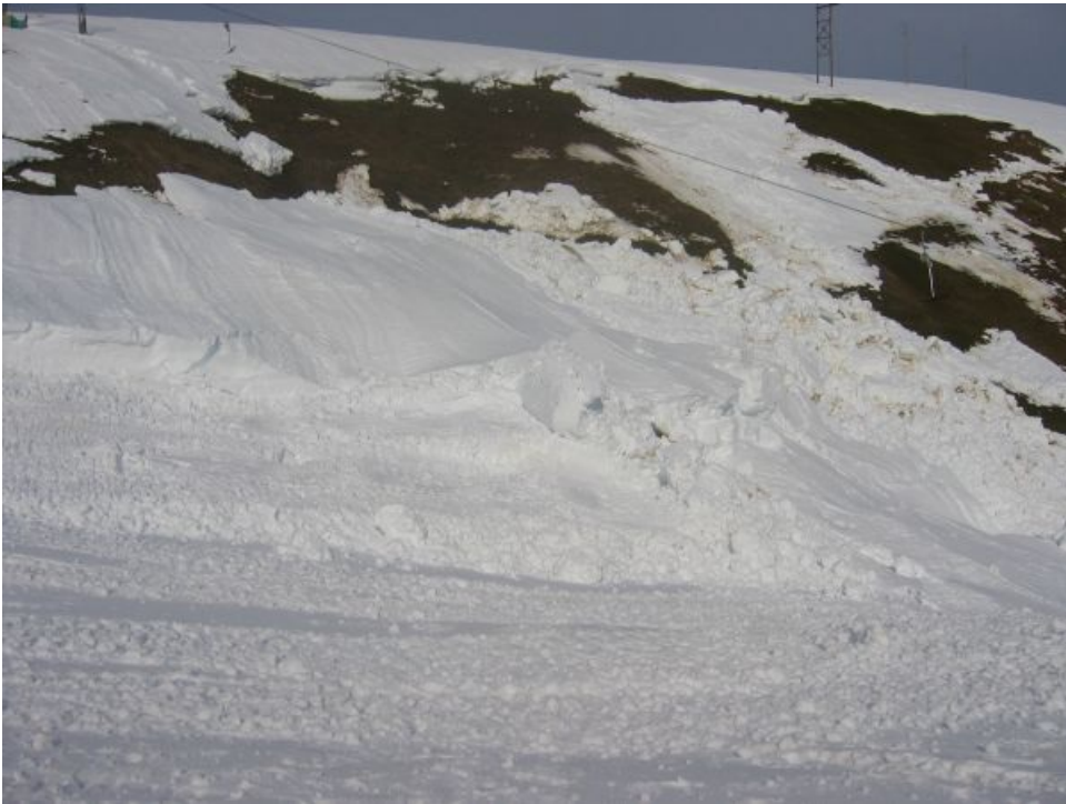
Mit dieser Gleitschneelawine im Gebiet Gitschenen (Isenthal, UR) hat sich ein Teil des Skilifttrasses vorübergehend verabschiedet (Foto: M. Bissig, 23.12.2012).
