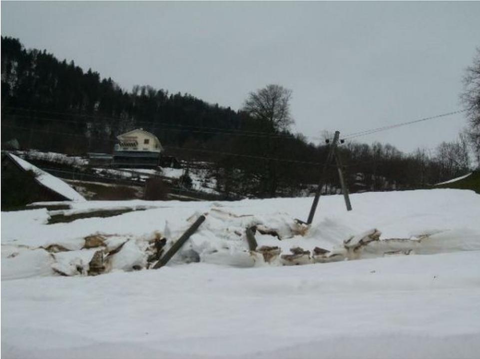
*Lawinen können auch in tiefen Lagen Schäden anrichten. Bewohner von Amden (900 m, SG) hatten am 16.12. während einiger Stunden keinen Strom, weil ein Gleitschneerutsch einen Strommasten knickte (Foto: P. Gerber, 17.12.2012).*
