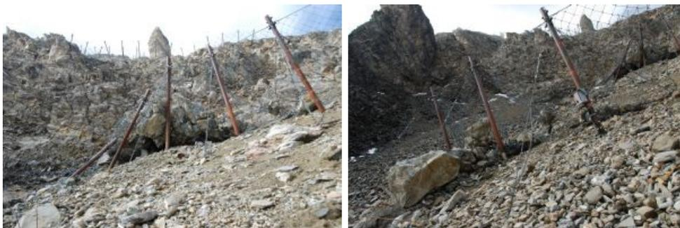
Photos 4a et 4b: Filets à neige endommagés (à gauche) et trou de forage (à droite) recouvert de pierres au-dessus d'Arolla, VS (photos: SLF/M. Phillips 06.09.2012).
