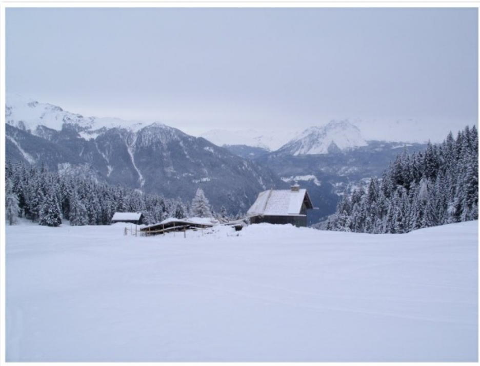
Der Last des Schnees nicht standhalten konnte dieses Gebäude bei Aclas Spondas oberhalb von Alvaneu (Foto: SLF/R. Meister).
