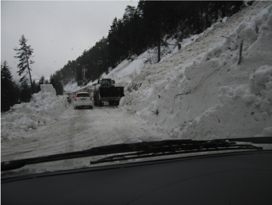
Die Kantonsstrasse zwischen Filisur und Bergün (GR) wurde mehrfach von Lawinen aus bewaldeten Strassenböschungen verschüttet. Hier am Sonntag, 26.02.2012 (Foto: SLF/L. Dürr).
