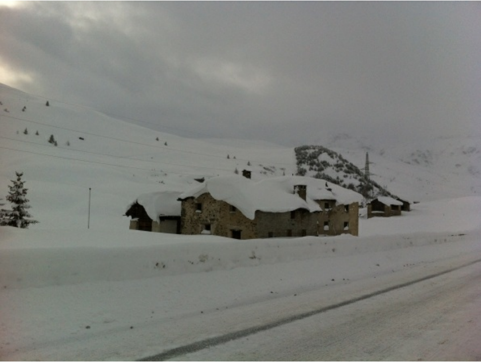
In diesem Winter haben Niederschläge aus Norden oft weit in den Süden übergreifen. In Bivio beispielsweise wurde an einem 26.01. in den letzten 59 Jahren noch nie soviel Schnee gemessen wie heuer. Auch diese tief verschneiten Gebäude an der Julierstrasse zeugen von den grossen Schneehöhen (Foto: J.-A. Bisaz, 21.01.2012).
