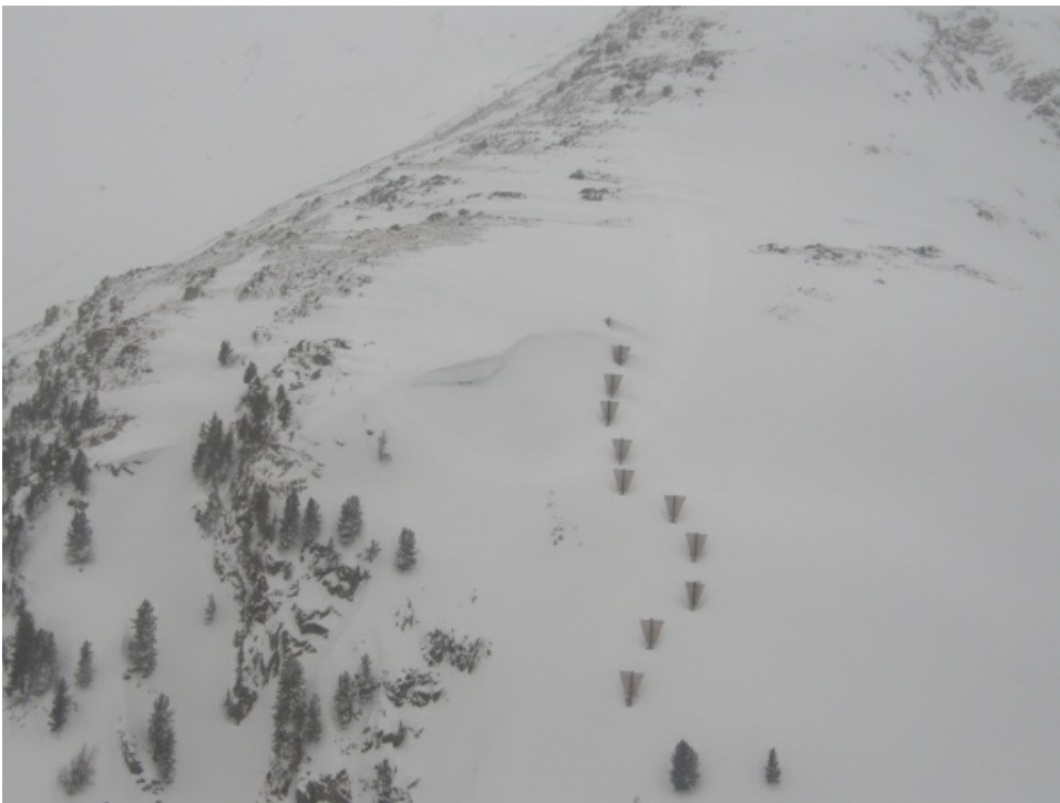
Die Kolktafeln im oberen Teil dieser Reihe sind teilweise eingeschneit und können ihre Aufgabe nicht mehr erfüllen. Ziel dieser Werke ist es, den Wind und damit die Schneeablagerung zu beeinflussen, sodass der Schnee weniger in die gefährdeten Hänge verfrachtet wird (Foto: P. Caviezel, 23.01.2012).
