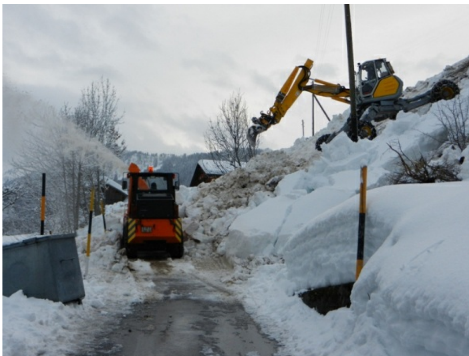
Photo 8: Pendant des jours, tout le manteau neigeux a lentement descendu la pente près Untervalzeina/GR (960 m) menaçant une route d'accès. Le 24 janvier, il a été décidé de s'attaquer au manteau neigeux d'une épaisseur de près d'un mètre au moyen d'engins lourds (photo: M. Balzer, 24.01.2012).
