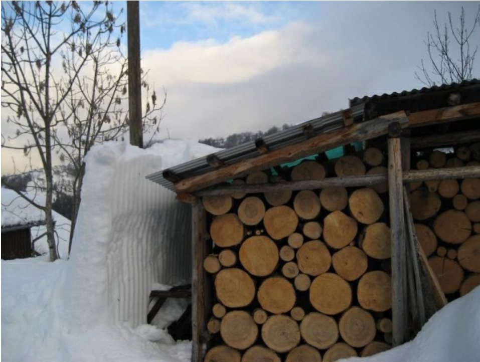
Gleitschnee - DAS Thema dieses Winters. Hier gleitet die Schneedecke von einem Wellblechdach und bleibt als Ganzes stehen (Peiden, Lugnez, GR) (Foto: M. Werder, 22.01.2012).
