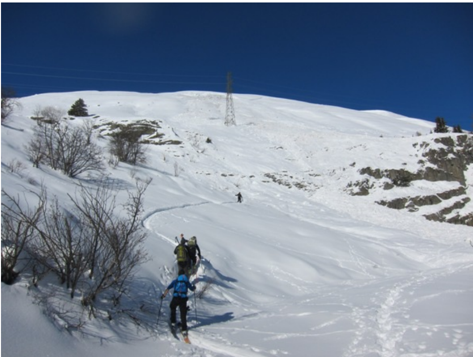
Le pylône a résisté à la grosse avalanche de glissement (au pied du mur du barrage du lac des Toules, Bourg-Saint-Pierre/VS) (photo: G. Sanga, 26.01.2012)
