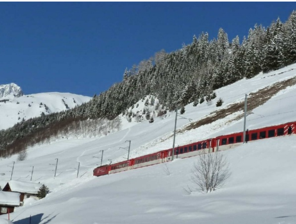
Auch die Bahnlinie der Matterhorn-Gotthardbahn ist an diesem Südhang auf 1400 m bei Sedrun, GR durch Gleitschneelawinen gefährdet (Foto: N. Levy-Schmid, 26.01.2012).
