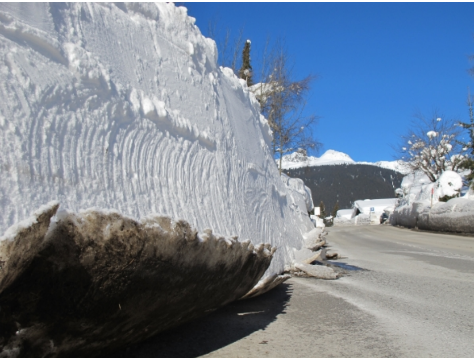
Wird die unterste Schneeschicht vom Boden her aufgeschmolzen, können Gleitschneelawinen oder auch Kriechschnee entstehen. Zur Offenhaltung der Strasse musste dieser an gewissen Stellen in regelmässigen Abständen weggefräst werden. Davos, GR (Foto: J. Rocco, 15.01.2012).
