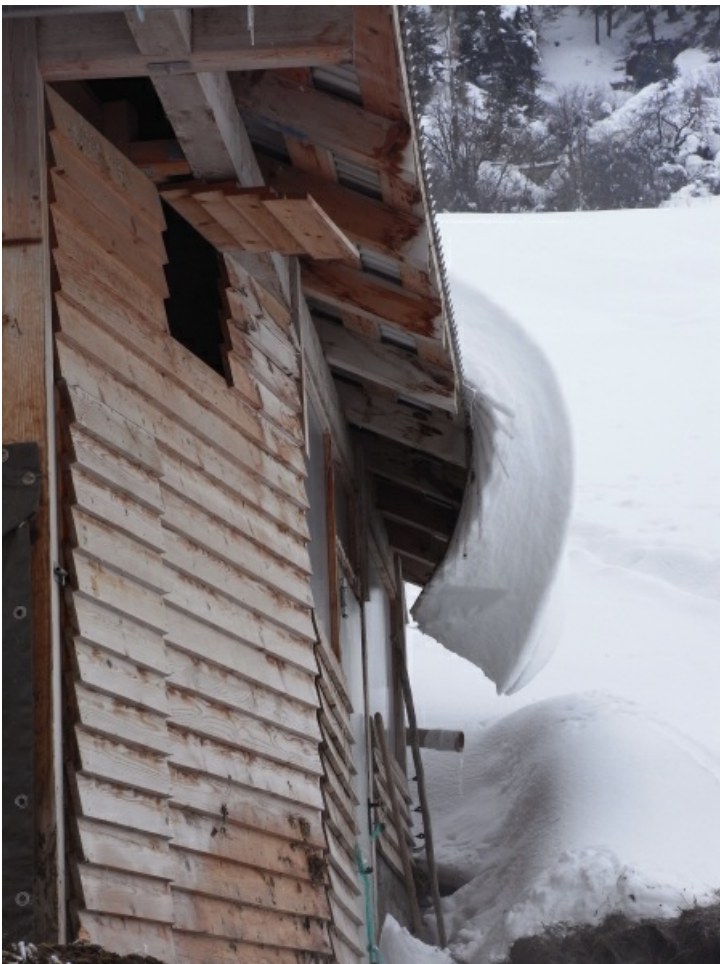
Kunst am Bau im Unterengadin (Foto: P. Caviezel, 18.01.2012).
