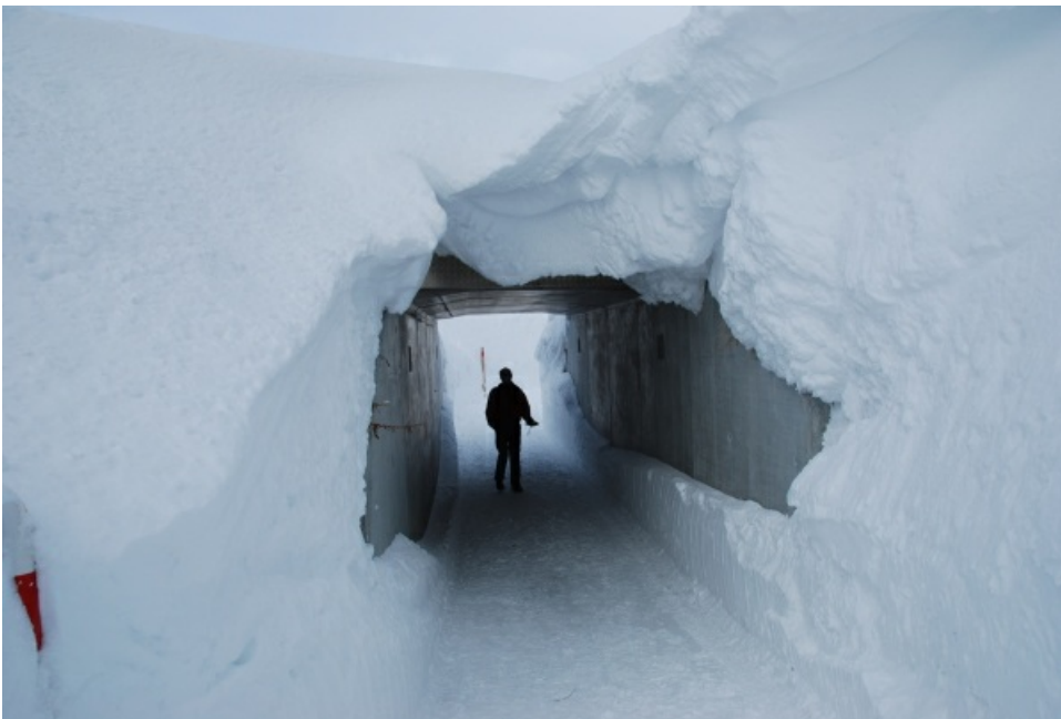
"Vordach" aus Triebsschnee bei einer Bahnunterführung in Davos, GR (Foto: SLF/M. Phillips).
