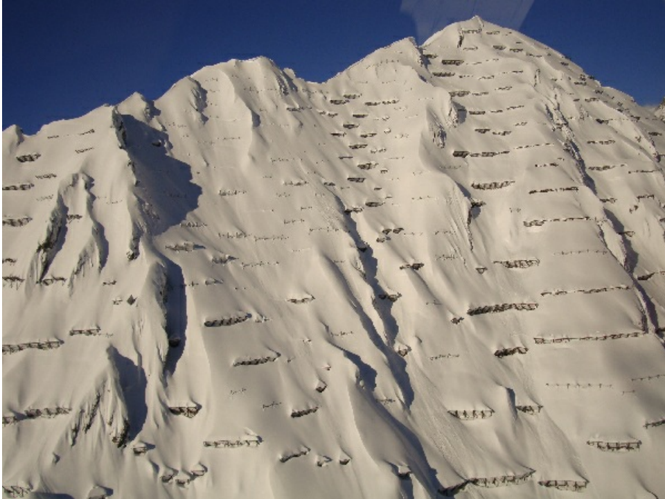
Photo 1: Il y a encore de la place dans les constructions paravalanches au-dessus de Gurnellen (UR). Des installations de retenue de neige sous la forme de barrières à neige en acier et de filets à neige comme sur cette photo au Geissberg (Witenstock, 2392 m) empêchent le départ d'avalanches et stabilisent le manteau neigeux. La hauteur de ces constructions de retenue varie d'une région à l'autre. Elle dépend des hauteurs de neige extrêmes possibles dans la zone de rupture. Pour ces hauteurs extrêmes, on se base sur des événements avec une durée de récurrence de cent ans. Dans le cas du dispositif paravalanche du Geissberg, la hauteur efficace des râteliers est, selon leur emplacement, de 3,5 ou 4 mètres. On peut ainsi retenir une hauteur verticale de neige d'environ 4,5 à 5 mètres (photo: H. M. Henny, 10.01.2012). Des informations complémentaires concernant les mesures de protection contre les avalanches peuvent être consultées ici .
