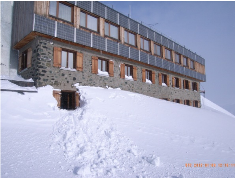
... und vor dem SLF-Institutsgebäude auf dem Weissfluhjoch (Davos, GR) (Fotos: R. Meister).
