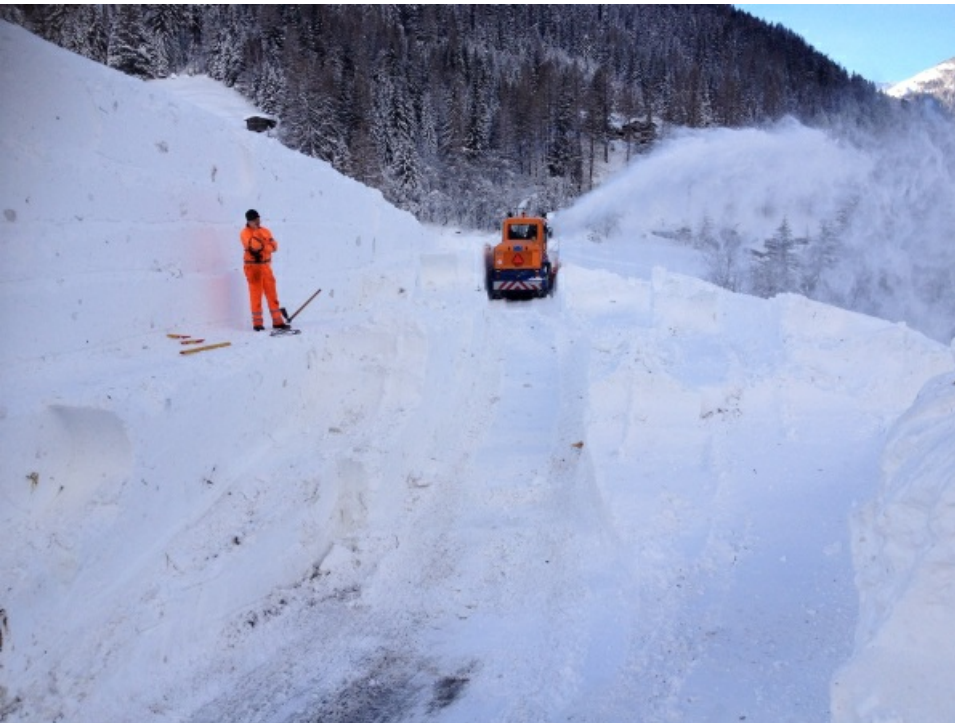
Räumungsarbeiten auf der verschütteten Strasse zwischen Binn und Fäld (VS, 1470 m). Die Lawine Tielöuwigraben ist in der Nacht vom Donnerstag, 05.01. auf den Freitag, 06.01. abgegangen. Breite ca. 120 m, maximale Ablagerungshöhe ca. 6 m (Foto: H. Gorsatt).
