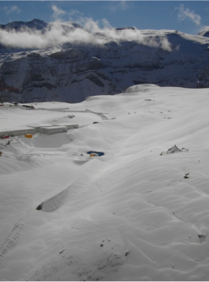
Der Lawenschutzdamm am Muttsee, GL (2500 m) ist stellenweise (im Bild links unten) mit Triebschnee bis zu 4 m hoch gefüllt (Foto: R. Stüssi, 09.10.2011).
