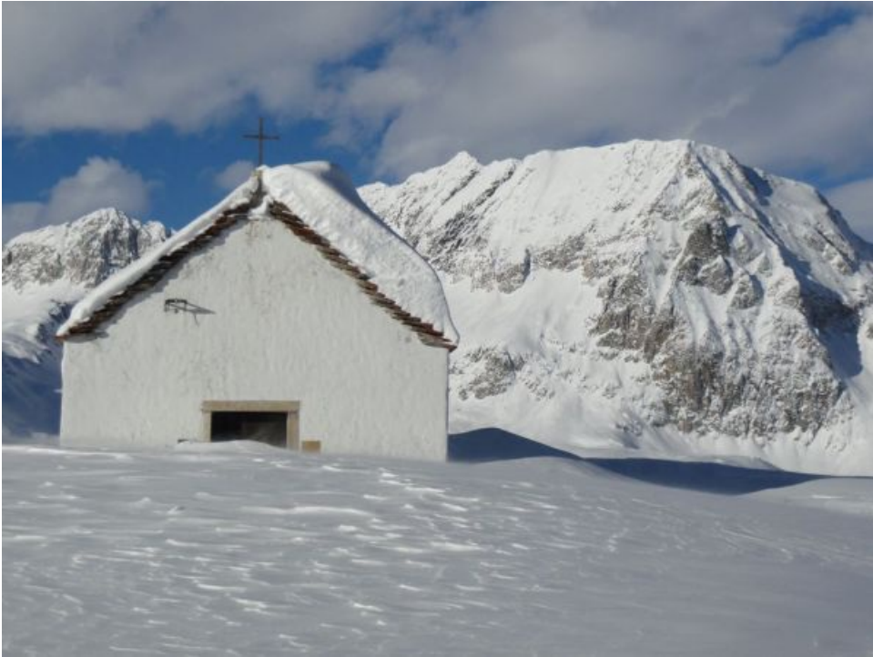
Passo San Giacomo, Übergang vom Kanton Tessin nach Italien, Ost-Südöstlich des Nufenenpasses. Die Kapelle mit deutlichen Zeichen von Schneeverfrachtungen auf dem Dach (von Westen nach Osten). Im Hintergrund der Poncione di Maniò (Foto: T. Schneidt, 20.12.2010).
