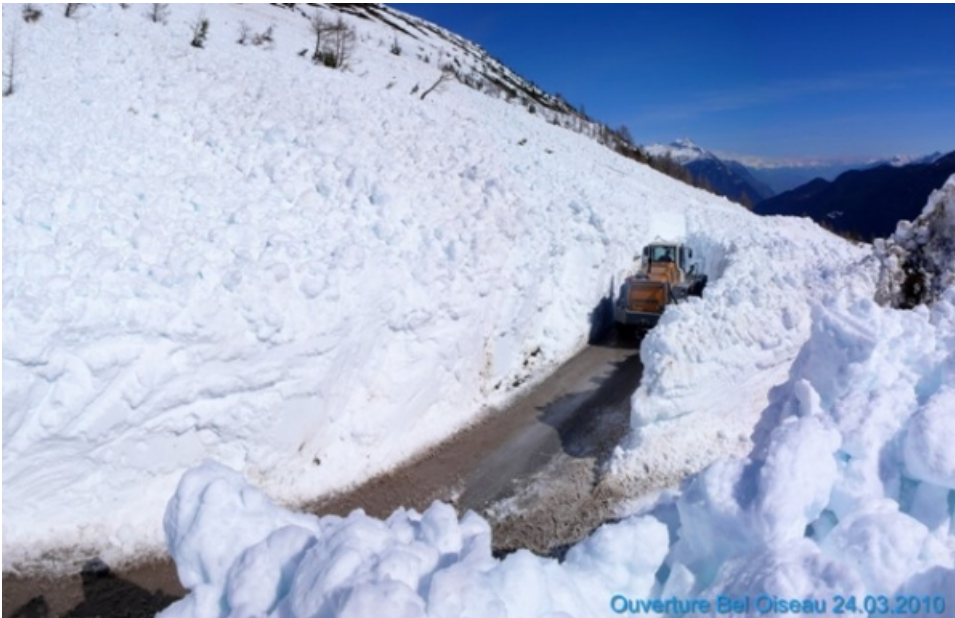
Réouverture pour la troisième fois cet hiver du passage de Golette à 1900 m située sur la route menant au barrage d'Emosson. La crue avalancheuse à ramené plus de 5 m d'hauteur de neige sur plus de 300 m dans ce couloir (Photo: J.L. Lugon, 24.03.2010).
