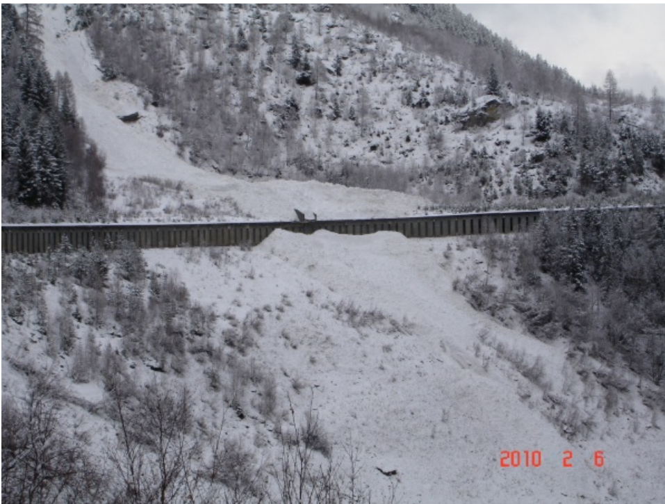
Ablagerungsbereich derselben Lawine bei der Lawinengalerie (Foto: P. Caviezel, 11.02.2010).
