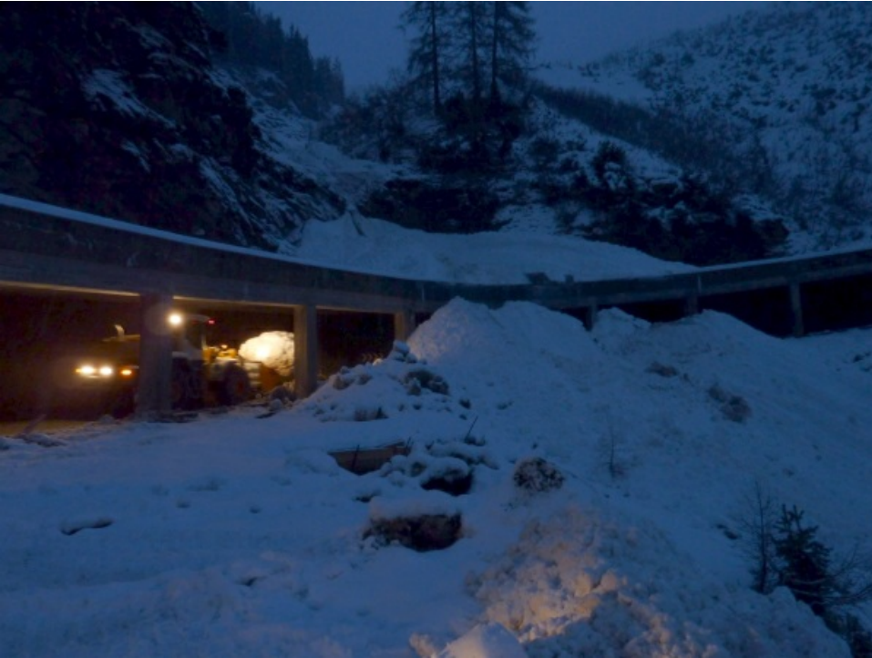
Eine von vielen Lawinen im Unterengadin am Freitag, 25.12. Diese Lawine im Val da Barcli (Val dal Spöl, Unterengadin, GR) hat die Galerie der geschlossenen Ofenpass-Strasse überführt (Foto: P. Caviezel).
