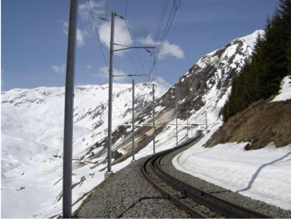
Photo 7: La dernière avalanche à ce jour au Calmut, col de l'Oberalp, GR s'est produite le dimanche soir 5 avril, au-dessus de la Galerie de la ligne ferroviaire Cervin Gothard. Par la suite, la pente était en grande partie purgée de sorte que l'activité avalancheuse avait plutôt diminué les jours suivants (photo: N. Levy, 6.4.2009).
