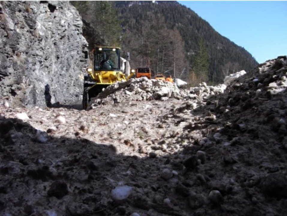
Lawinenschnee oder Erdbeben? Gehen grössere Lawinen am Boden ab, können sie viel Erdreich mitnehmen. Räumung des Kegels der Lawine Val Pischödt vom Donnerstag, 2.4. Unterengadin, GR (Foto: P. Caviezel).
