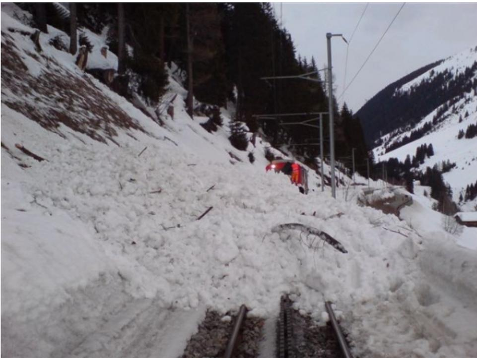
Die Matterhorn-Gotthard Bahn wurde bei Sedrun an einigen Stellen von Gleitschneelawinen verschüttet. Die grösste (hier im Bild) brachte auch etwas Holz mit (Foto: R. Levy, 02.03.2009).
