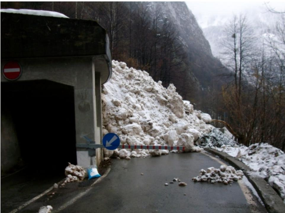
*Die Lawingalerie im zwischen Veia und Cartignelli im Val Peccia, obere Maggiatäler, TI wurde von einer feuchten Lawine überflossen. Auch hier musste schweres Gerät eingesetzt werden um die ungeschützte, äussere Fahrbahn vom Schnee zu befreien (Foto: F. Piazzini, 03.03.2009).*
