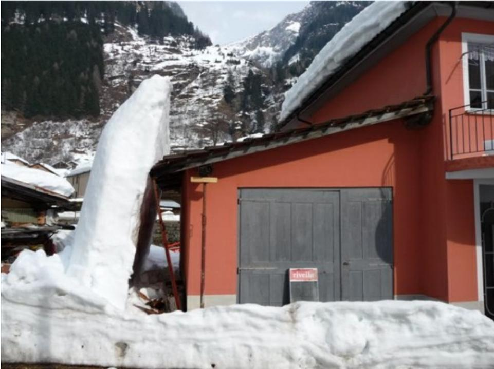
Die gefährliche Sorte der Dachlawine: Die Schneedecke hat sich durch Eisbildung derart verfestigt, dass der Schneeblock beim Sturz nicht zerbrach (Foto: S. Fehler, 02.03.2009).
