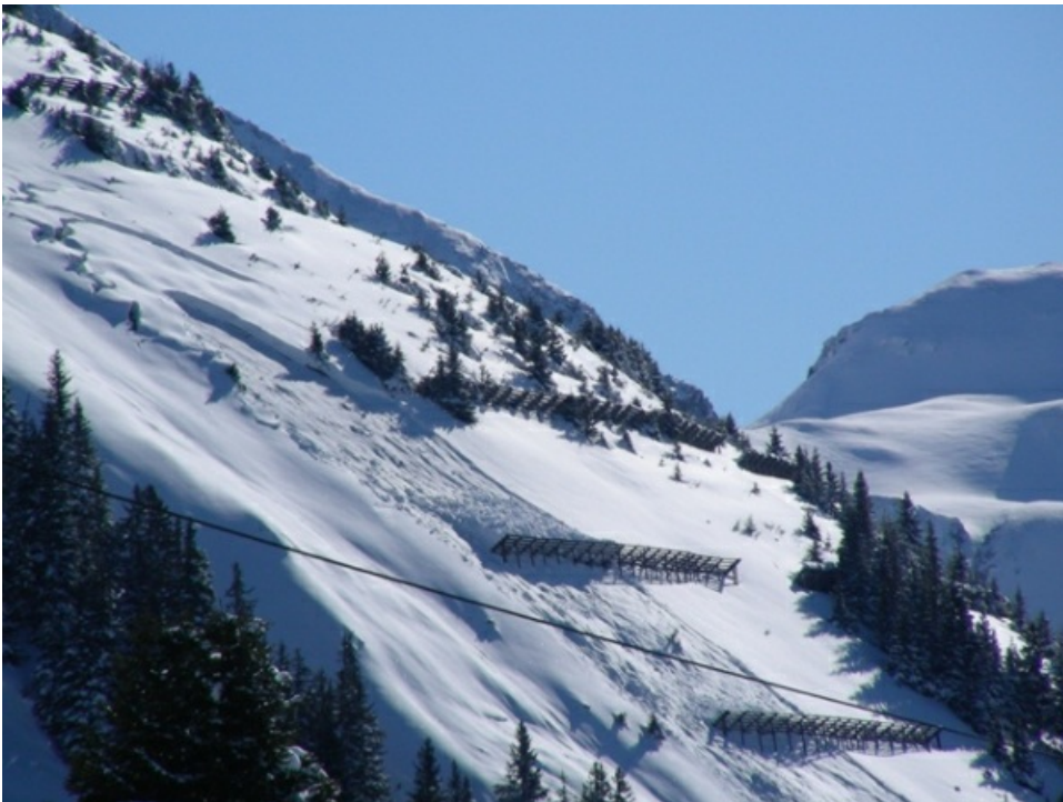
Gleitschneelawine am Mattjisch Horn (Schanfigg, GR) auf etwa 2000 m an einem Südwesthang. Links oben im Bild, über dem Anriss, sind weitere Risse zu sehen. Die primäre Funktion dieser Lawinenverbauungen ist einen grösseren Anriss zu verhindern und nicht - wie hier - abgeglittenen Schnee aufzufangen (Foto: M. Balzer, 25.02.2009).
