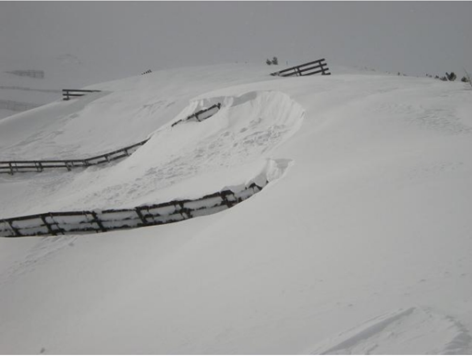
Teilweise können Lawinverbauungen mit Triebschnee gefüllt sein - so wie hier am Grünenberg (Landschaft Davos, GR). Noch erfüllen sie ihre Aufgabe (Foto: R. Wick, 24.02.2009).
