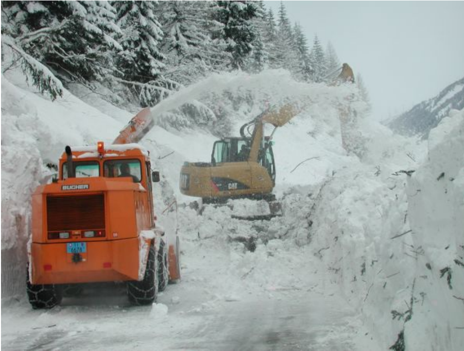
Den Schneemassen ist nur mit schweren Baumaschinen beizukommen. Öffnung der Strasse nach Villa di Bedretto, 1362 m, TI welche auf einer Länge von rund 70 m verschüttet wurde. Die Strasse war dabei gesperrt und es kam niemand zu Schaden (Foto: G. Valenti, 10.02.2009).
