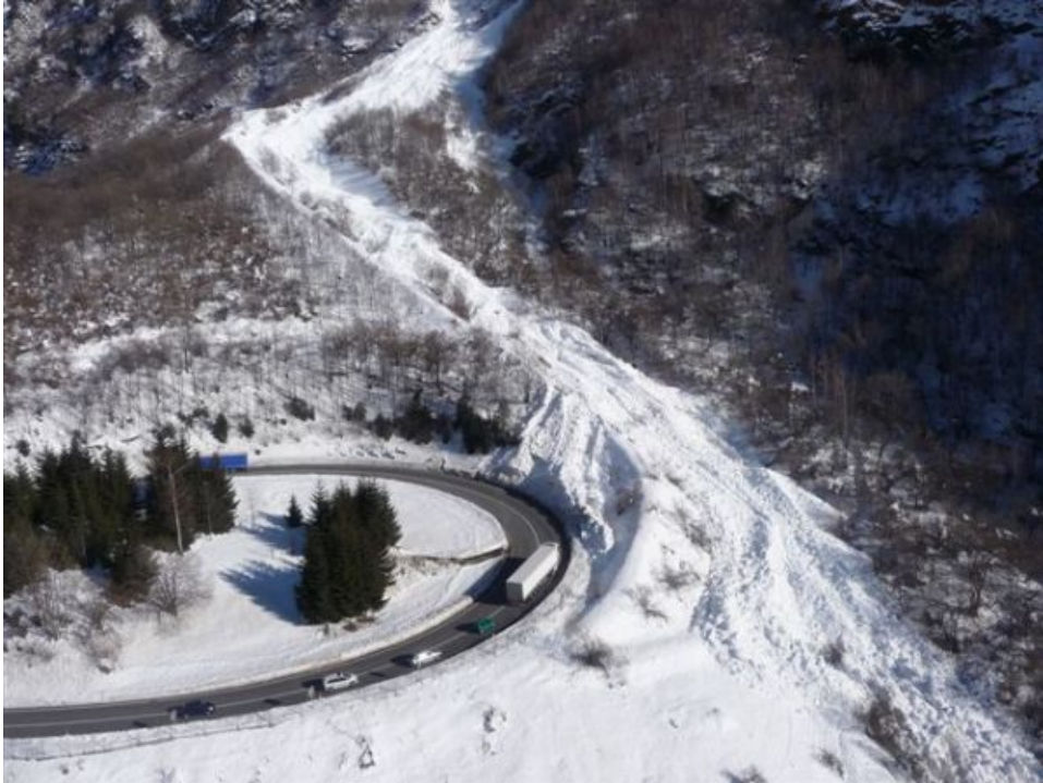
Photo 1: La route de San Bernardino (A13) a été ensevelie par l'avalanche de Manzei, le 07.02.2009 au-dessus de Mesocco (GR) à une altitude d'environ 1000 m. La zone derrière la digue de déviation a été comblée de neige et un bras d'avalanche a franchi la digue jusque sur la route encore ouverte. Personne n'a été touché! La route est ensuite restée fermée pendant une dizaine d'heures (photo: S. Fehler 09.02.2009).
