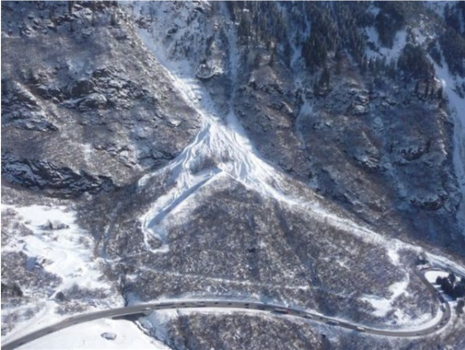
Der Ablenkdam hat schlimmeres verhindert. Die Marzeilawine oberhalb Mesocco, GR, welche in der Nacht auf Samstag, 07.02.2009 spontan abgegangen ist wurde durch den Damm geteilt und abgelenkt, sodass nur ein kleiner Arm auf die Strasse floss (Foto: S. Fehler, 09.02.2009).
