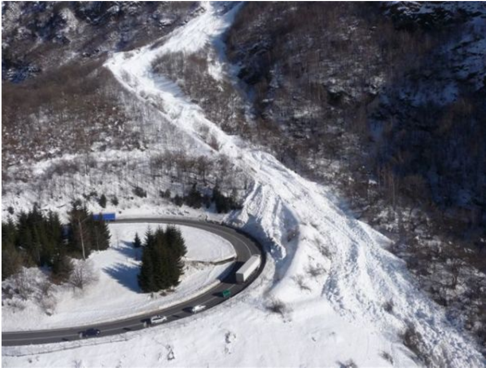
Abb. 1: Die San Bernardino Route (A13) wurde am 07.02.2009 oberhalb von Mesocco, GR auf einer Meereshöhe von rund 1000 m von der Manzeilawine verschüttet. Das Gelände hinter dem Ablenkdammbauwerk wurde aufgefüllt, und ein Lawinenarm floss über den Damm auf die offene Strasse. Es kam niemand zu Schaden. Die Strasse blieb danach während rund zehn Stunden gesperrt. (Foto: S. Fehler, 09.02.2009).
