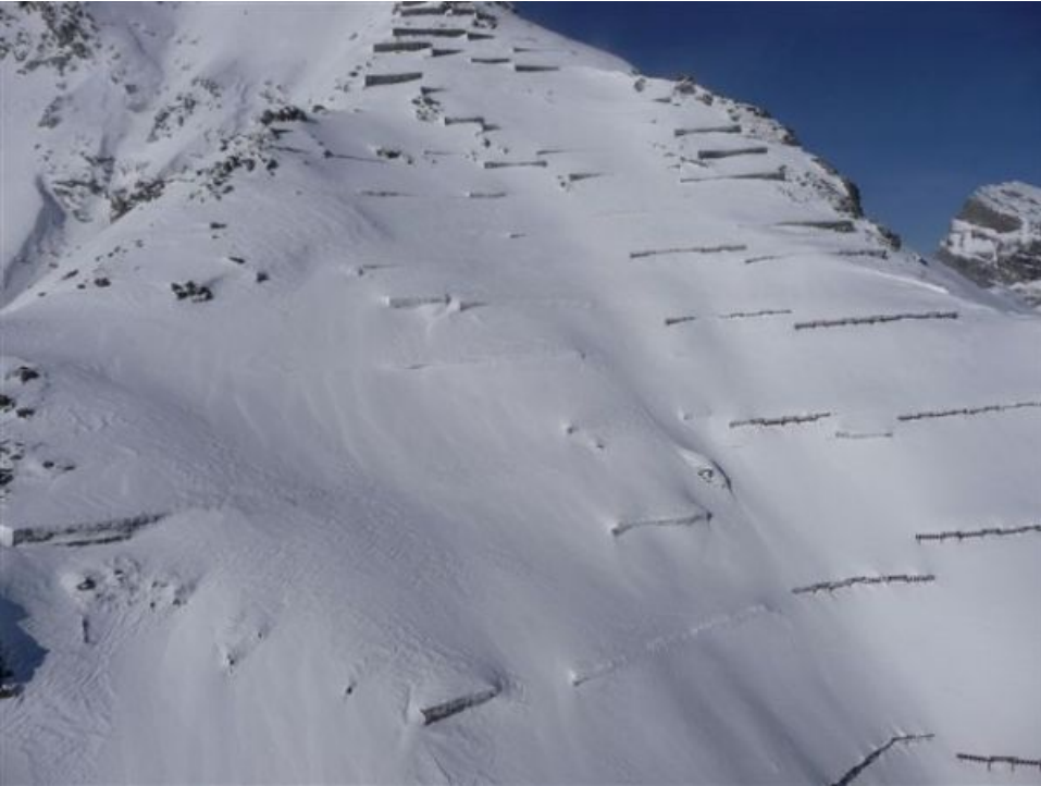
Die Lawinerverbauungen am Osthang des Forcel, rund 2200 m oberhalb von Landarenca, Calancatal, GR sind fast mit Schnee gefüllt. Bei weiteren Starkschneefällen in dieser Region könnten die Verbauungen in Zukunft ihre Schutzwirkung nur noch teilweise erfüllen (Foto: S. Fehler, 09.02.2009).
