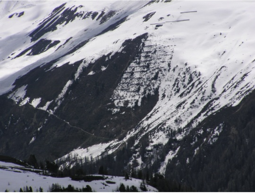
Unterschiedliche Ausaperung zwischen einer verbauten und einer unverbauten Fläche am Stillberg, rund 2200 m, Davos, GR. In der unverbauten Fläche ist die Schneedecke abgerutscht, während sie in der verbauten Fläche langsam abschmilzt (Foto: SLF/C. Pielmeier, 23.05.2008).
