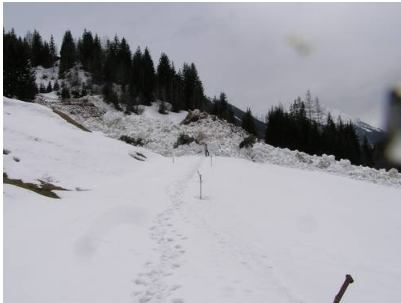
Photo 4: Dépôts de neige mouillée de l'avalanche Taferna près de Davos, GR. Cette avalanche s'est produite le vendredi midi 11 avril, probablement à la suite du réchauffement et de la pluie tombée jusqu'à haute altitude. Elle a passé une galerie de route et est descendue jusque dans la Landwasser (photo : ENA/C. Pielmeier, 14.04.2008).
