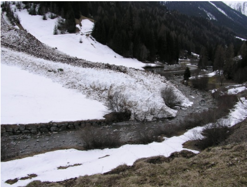
Die Taferna Lawine bei Davos, GR hat die Lawinengalerie überflossen und ist bis ins Landwasser vorgedrungen. Die Lawine wurde am Freitag, 11.04. wahrscheinlich durch Regen und Wärme ausgelöst (Foto: SLF/C. Pielmeier, 14.04.2008).
