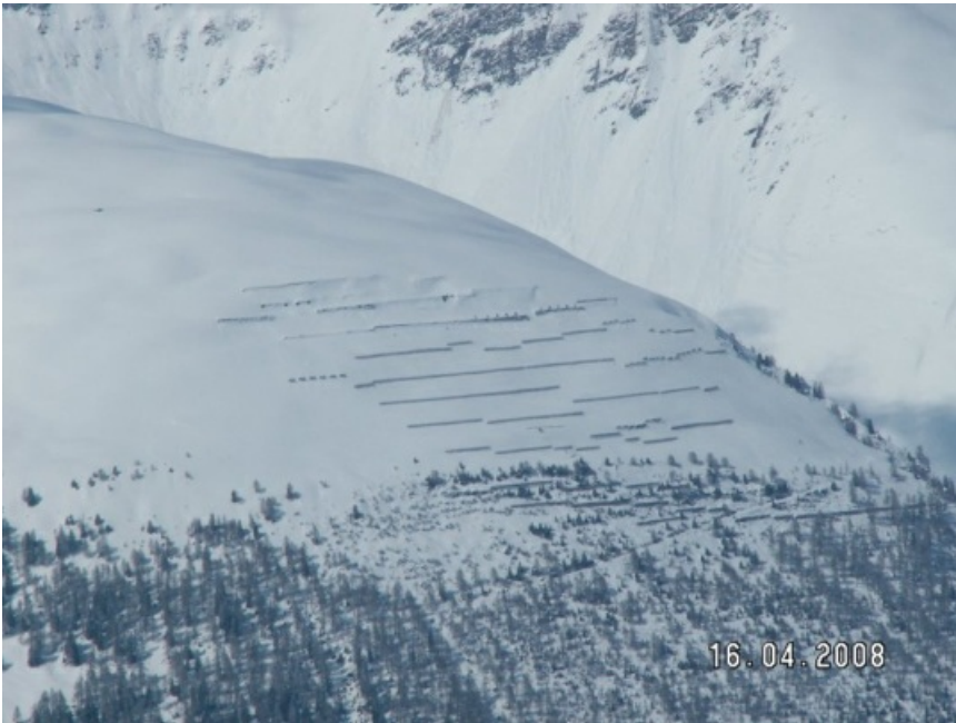
Die Lawinverbauungen haben in diesem Winter viel zu tun. An diesem Südwesthang auf rund 2200 m oberhalb von Obergesteln, VS sind die obersten Werksreihen eingeschneit (Foto: SLF/Th. Stucki, 16.04.2008).
