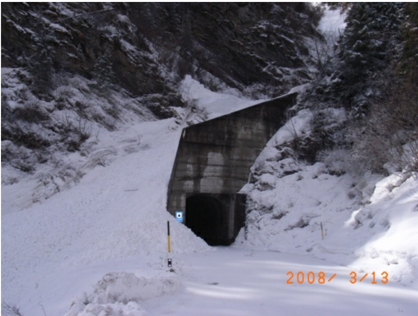
Die gesprengte Lawine im Val Mundin, Samnaun, GR riss einen beträchtlichen Teil der teils feuchten Altschneedecke mit und stiess bis über die Kantonsstrasse auf 1500 m vor (Foto: P. Caviezel, 13.03.2003).
