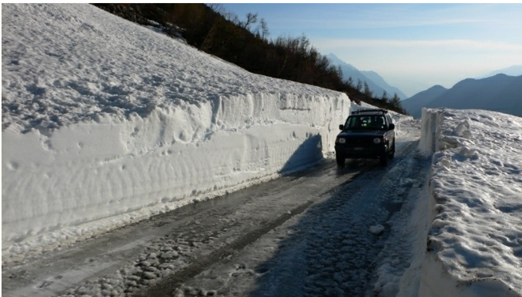
L'ouverture de la route de Finhaut à Emosson. Il y a longtemps qu'il y a si peu de neige lors de l'ouverture. Seulement 2 journées de machines pour arriver à Emosson. Couloir de Golette à 1900 m (Foto: J.-L. Lugon, 24.04.2007).
