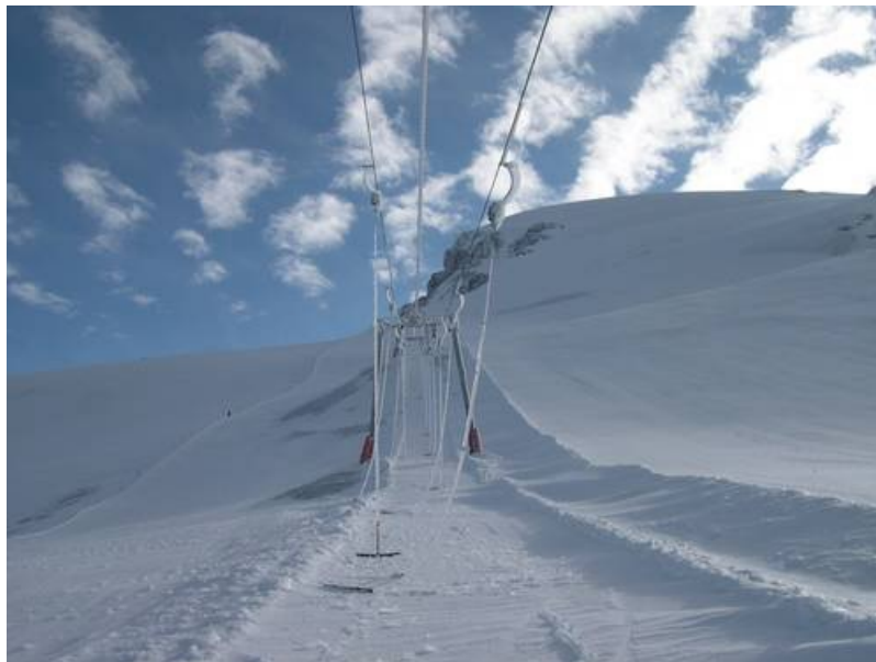
Photo 5: Le vent soufflant en tempête et la pluie ont laissé leurs traces. Une croûte de glace s'est formée sur toutes les parties saillantes mais également dans la surface neigeuse. Ici au Titlis, exposition est-ouest, à plus de 2600 m (photo: Chr. Bissig, 20.01.2007).
