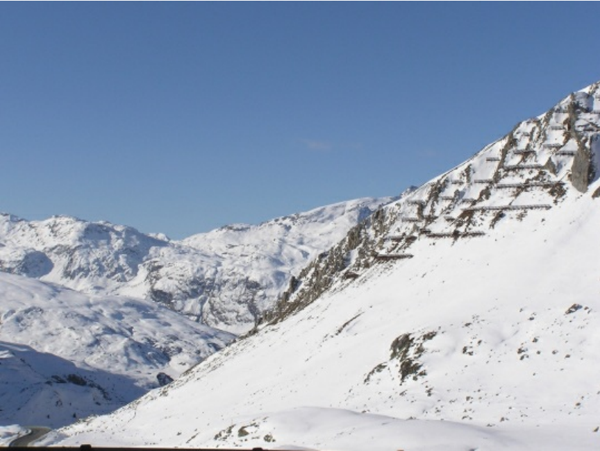
Die Lawinverbauungen am Julierpass, GR hatten diesen Winter noch wenig zu tun. Südhang, ca. 2300 m (Foto: SLF/C. Pielmeier, 14.01.2007).
