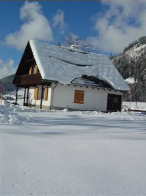
Die ersten Dachlawinen "donnern" von den Dächern, Toggenburg, SG (Foto: P. Diener, 10.12.2006).
