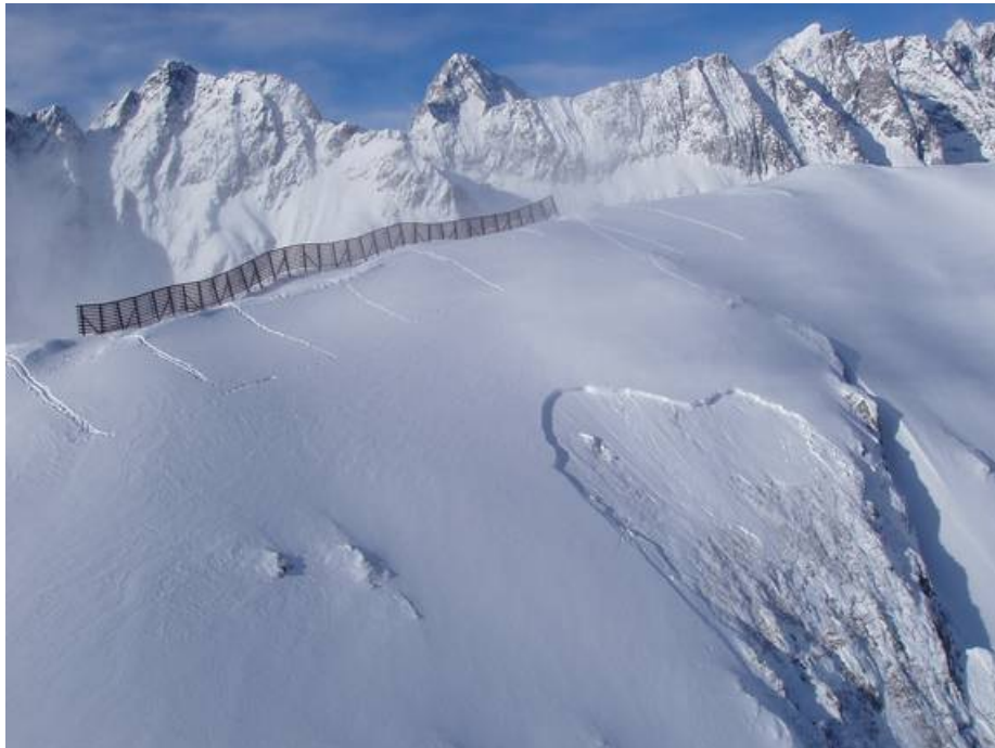
Photo 10: Avalanche déclenchée à distance au cours de travaux de mesure à hauteur d'une barrière anti-congère le mercredi 26 janvier au Bälgrat, au-dessus de Belalp, VS. La rupture se situe à 2520 m sur une pente raide exposée à l'est. La plaque de neige s'est décrochée sous les rochers jusque dans le manteau de neige ancienne (photo: P. Schwitter, 26.01.05).
