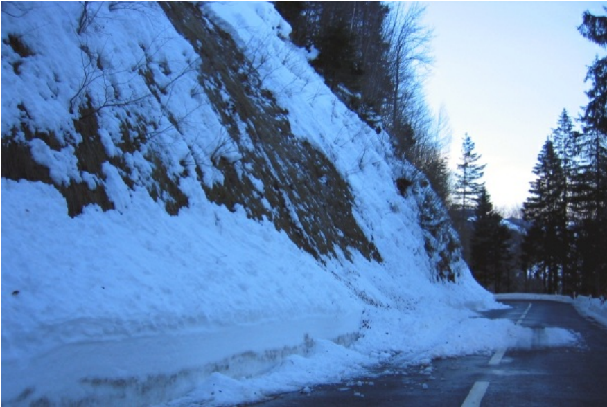
Mit der starken Erwärmung von Freitag, 30.01. auf Samstag 31.01. wurde der Schnee in tiefen Lagen feucht und schwer. An extrem steilen, glatten Grasbörtern glitt die gesamte Schneedecke relativ rasch ab und konnte exponierte Verkehrswege teilweise verschütten. Strasse Steg - Hultegg auf rund 800 m im Zürcher Oberland. Foto: SLF / L. Stoffel, 01.02.2004
