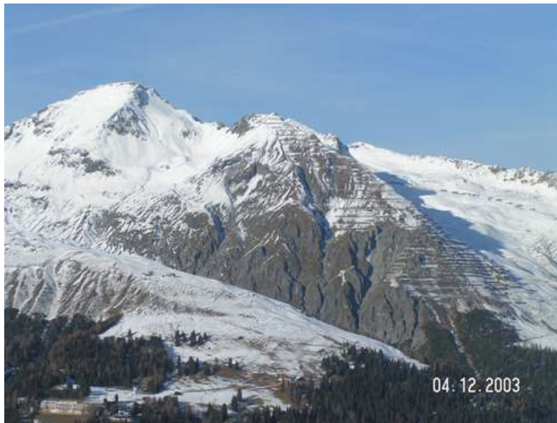
Abb. 4: Schneelage in Davos am 4.12.03. Steile Sonnenhänge sind bis 2400 m aper, unterhalb von 2200 m liegt kaum eine geschlossene Schneedecke. Im Vergleich dazu liegt am Alpennordhang noch weniger. (Foto: Thomas Wiesinger, SLF / Schiahorn mit Lawinenverbauungen, links unten Hotel Schatzalp)
