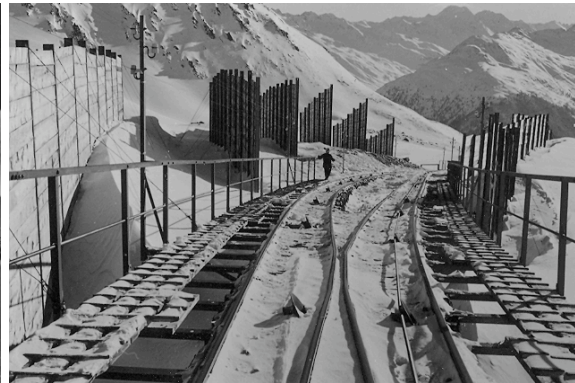
Abb. 12: Gestaffelte Verwehungsschutzwände auf der Davos-Parsenn-Bahnlinie. 291
