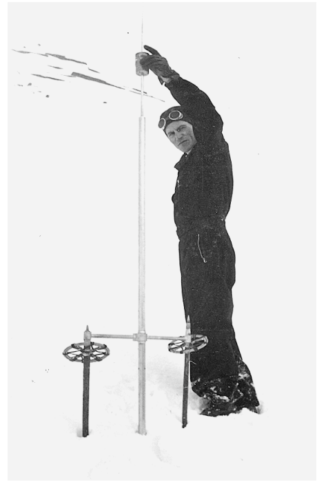
Abb. 8: Kegelsonde zur Bestimmung des Rammwiderstandes. 265
