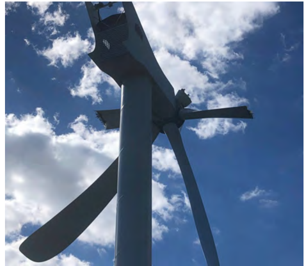
Abbildung 144: Beschädigtes Windrad beim Restaurant Gamplüt (Lawine Nr. 87)(Foto: K. Winkler, 03.06.2019)
