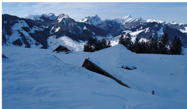
Abbildung 146: Zerstörte und beschädigte Alphütten auf der Alp Ahorn (Lawine Nr. 53)(Foto: SLF/M. Hohl, 19.01.2019)
