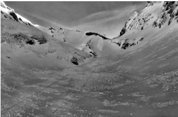
Abbildung 142: Beschädigte Materialseilbahn am Rotsteinpass (Lawine Nr. 66)(Quelle: Facebook)
